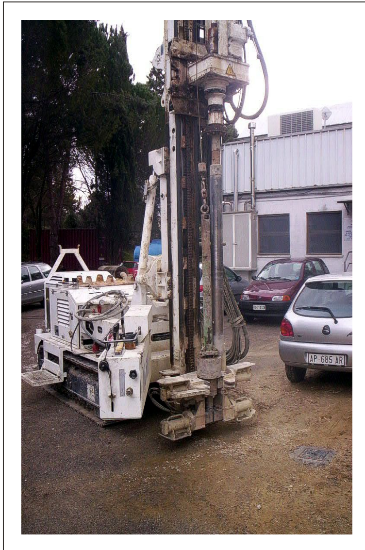
Postazione Sondaggio S1 Cantiere: Passo Varano (AN)
