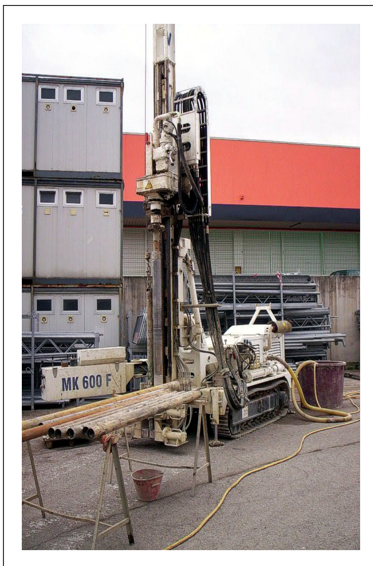
Postazione Sondaggio S3 Cantiere: Passo Varano (AN)
